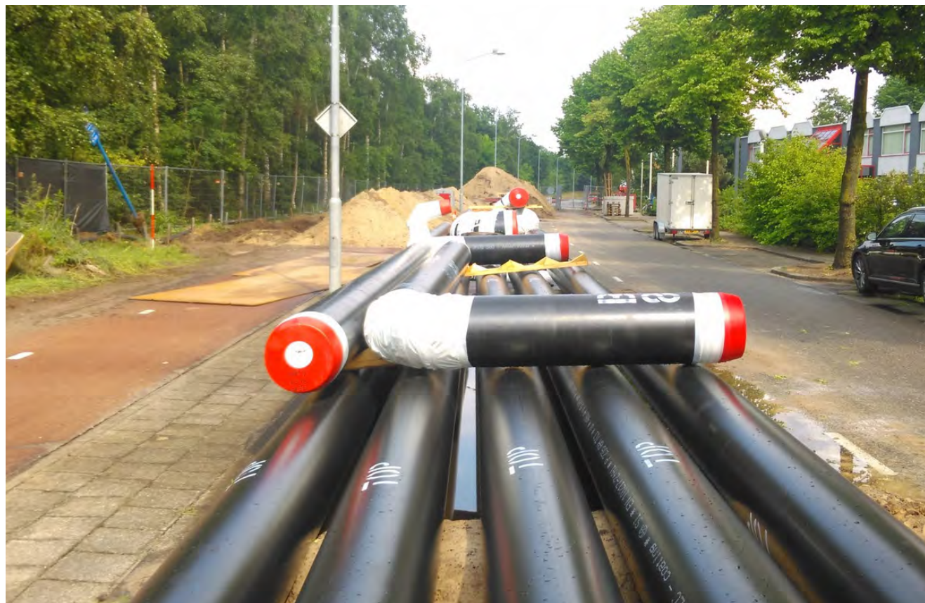
Aanleg van warmtenet (foto: Warmtebedrijf Ede)
