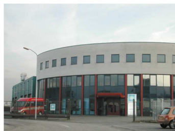
Grotendeels glazen bedrijfsgevel op het bedrijventerrein 'De Geerden'.
