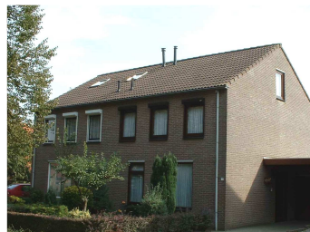
Horizontale geleding door plaatsing van de ramen en het dakvlak.
