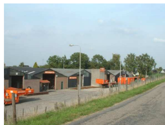
Bedrijfshallen tussen de Maasdijk en Burgemeester van Randwijkstraat te Rossum.
