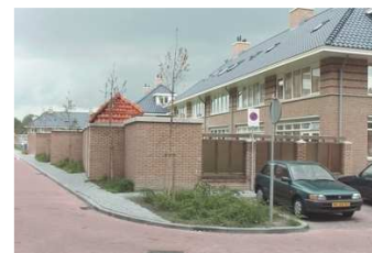
Niet passend door afwijkende kapvorm.
