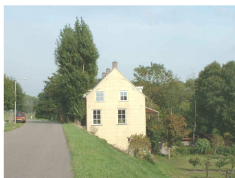
Kleinschalige dijkbebouwing te Hurwenen.
