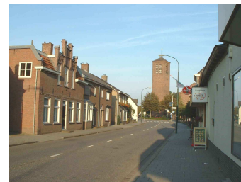
Gesloten gevelwanden waarin de panden individueel herkenbaar zijn gebleven.
