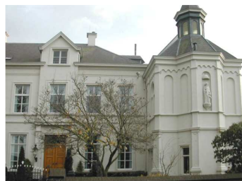
Grootschalig monumentaal pand tegenover het kerkgebouw te Velddriel.
