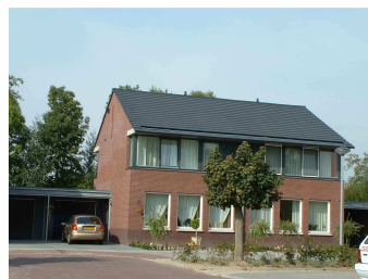
Woningen met sterk horizontale geleding door plaatsing van ramen en het zadeldak in de langsrichting.
