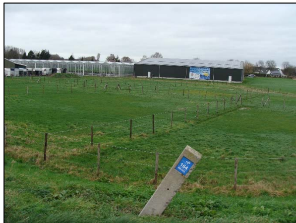
Foto 3. Overzicht plangebied vanaf dijk
