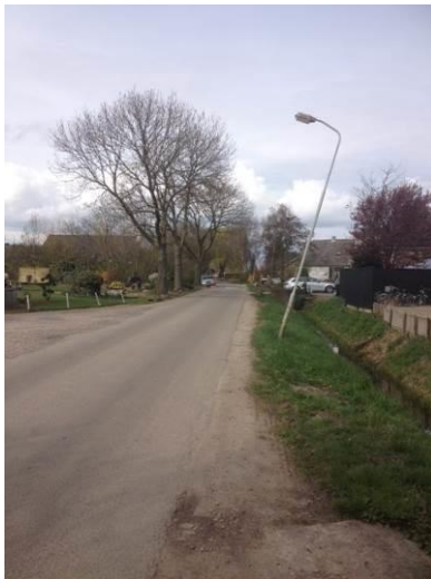
Figuur 13: Scheve lichtmast
