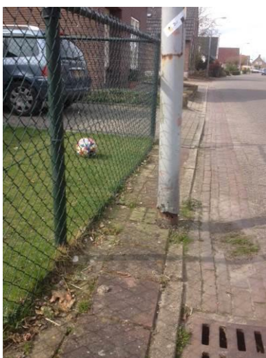
Figuur 12: Mast die in aanmerking kwam voor vervanging. Inmiddels is deze lichtmast vervangen door een aluminium mast met led-armatuur
