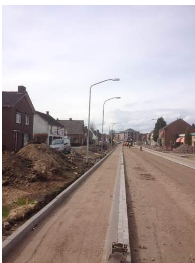
Figuur 10: Civiele werkzaamheden gecombineerd met OVL
